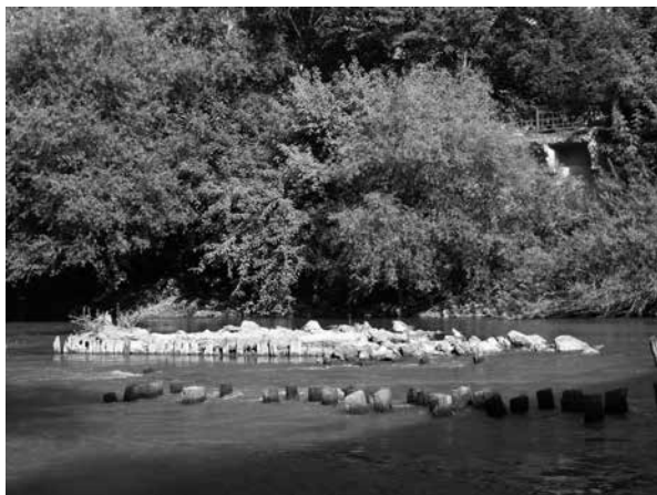
Az 1920-as években emelt közműhíd pillérmaradványa, a háttérben a híd északi hídfejének részletével
